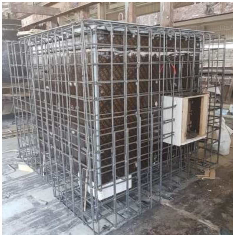
Figure 6. Armimi i pusetave të betonit
