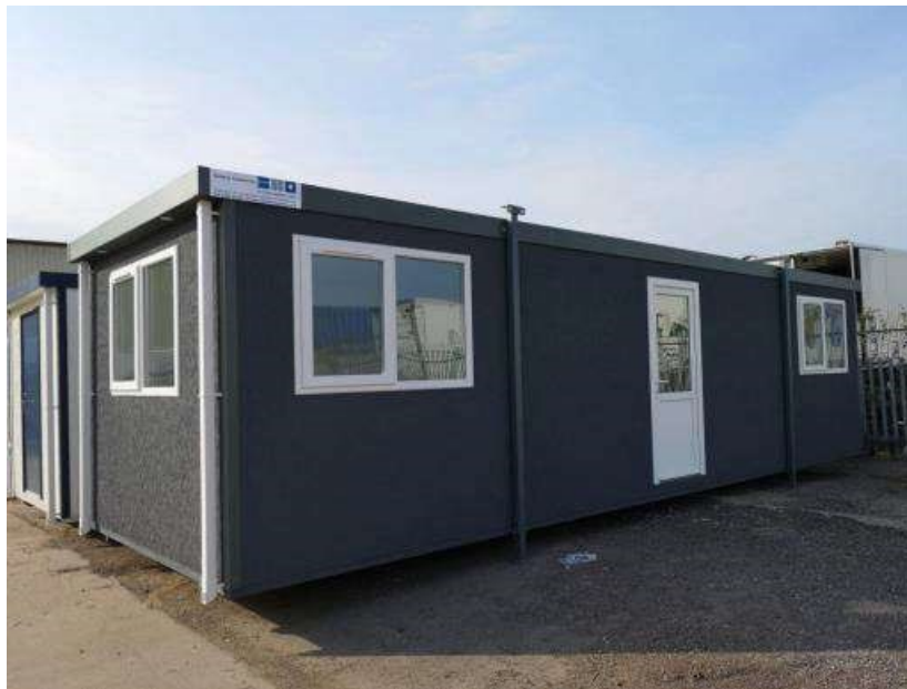
Figure 10. Vendbanim i përkohshëm në kantier ndërtimi Barakë e përkohëshme
