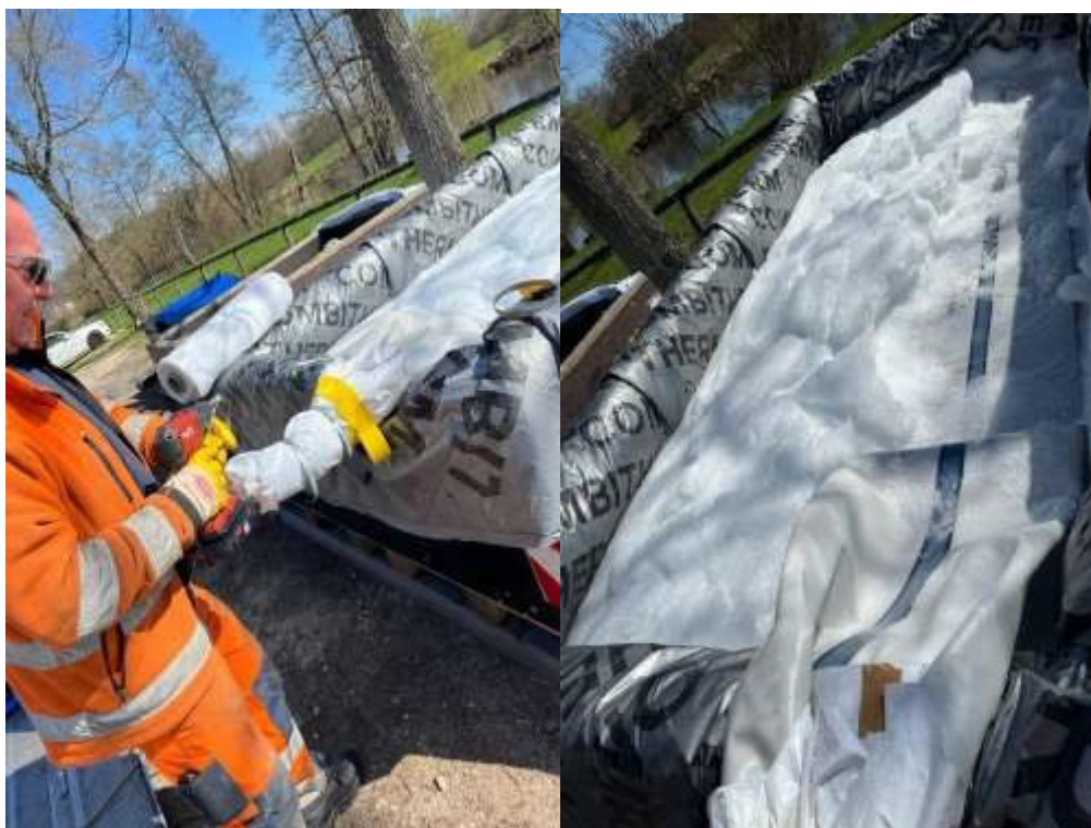
Figure 25. Sjellja e linerave ne vendpunishte te mbuluara me akull
