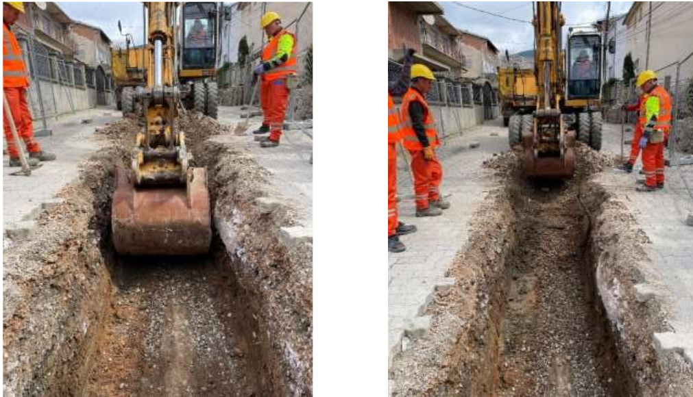
Figure 34. Gërmimi i kanalit
