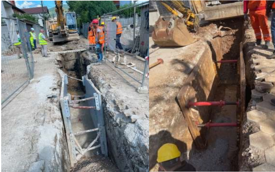
Figure 35. Mbrojtja e kanalit nga shembja e dheut
