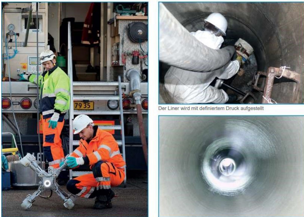
Figure 22. Teknika e shtrirjes dhe e ngurtësimit të UV-Liner
