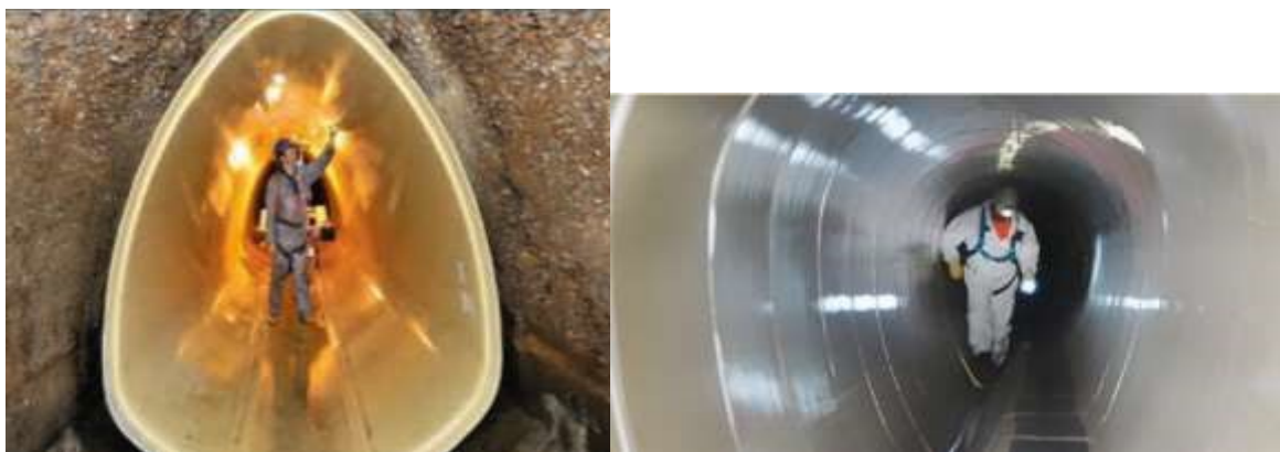
Figure 13. Pamje nga mbrendesia e kanaleve të renovuara
