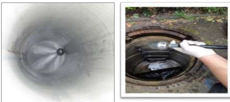
Figure 18 .Pajisja për pastrim hidromekanik të pusetes para fillimit të renovimit
