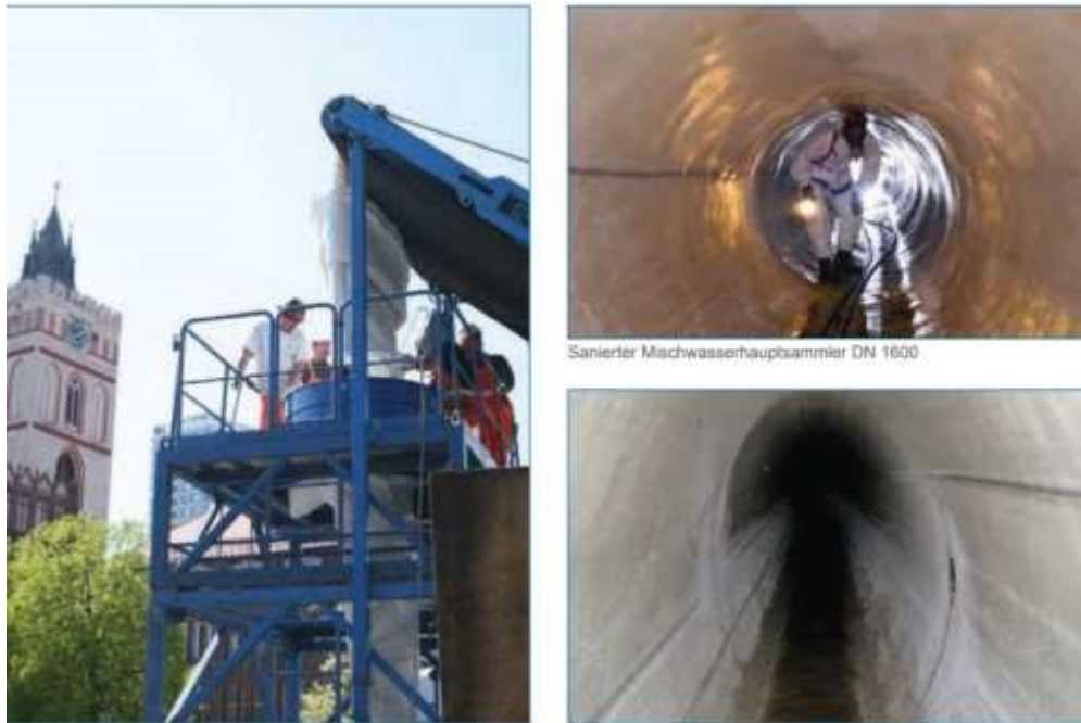
Figure 23. Metoda e shtrirjes dhe e ngurtësimit të Liner me anë të ujit të nxehtë
