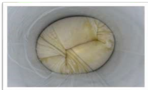
Figure 24. Procedura e shtrirjes së Linerit me ujë të nxehtë
