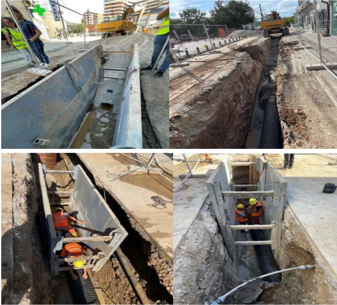
Figure 36. Shtrirja e gypave në kanal
