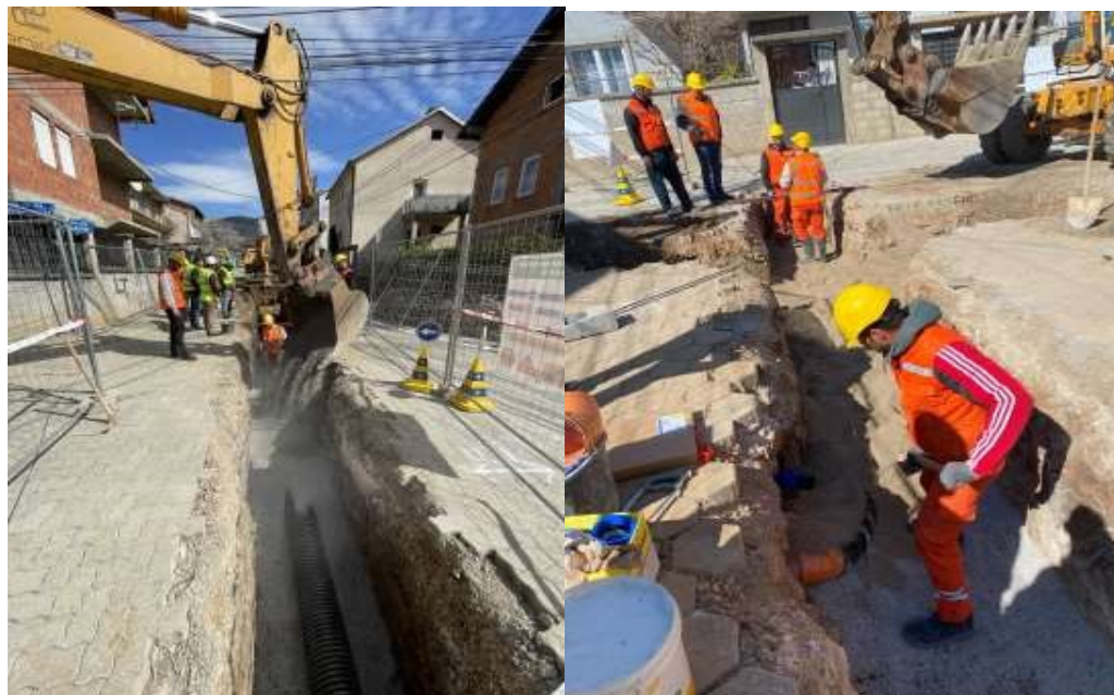
Figure 38. Procesi i mbulimit të gypave me zhavor dhe rërë të imët
