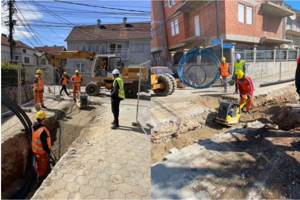
Figure 39.Ngjeshja e shtresave të kanalit me ngjeshje mekanike ‘bretkosë’
