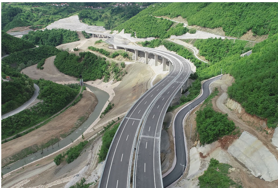
Figura 1 Autostrada Arbën Xhaferi, e kryer me llojin e kontratës Projektim-Ndërtim
