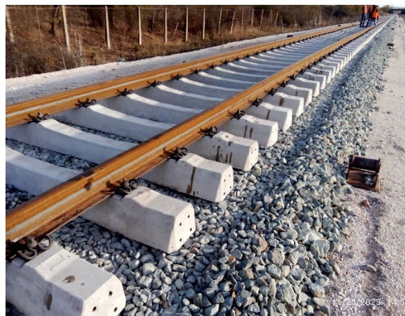
Figura 33 Vendosja e shtresës së parë të ballastit Figura 34 Vendosja e shinave dhe traversave
