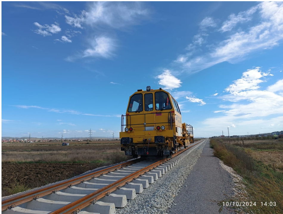
Figura 23 Fotografî e shinave, traversave dhe ballastit të vënë në vepër
