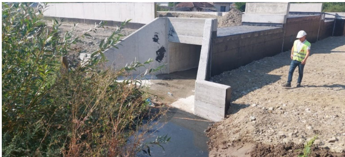
Figura 29 Fotografi e një lëshese hekurudhore me prerje drejtkëndore
