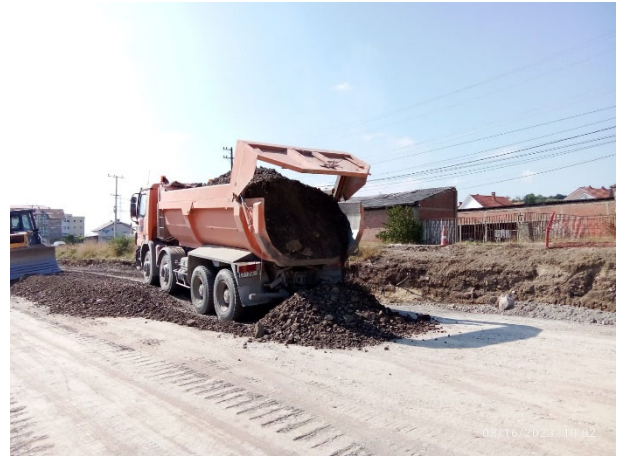
Figura 26 Ndërtimi i nënshtresave të trupit të hekurudhës - foto nga terreni
