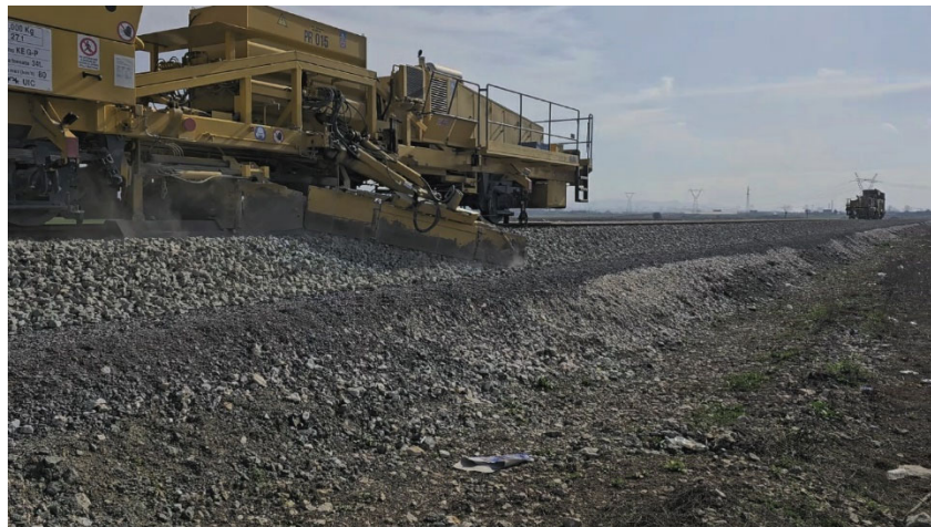
Figura 37 Procesi i formësimit të prizmit përfundimtar të ballastit
