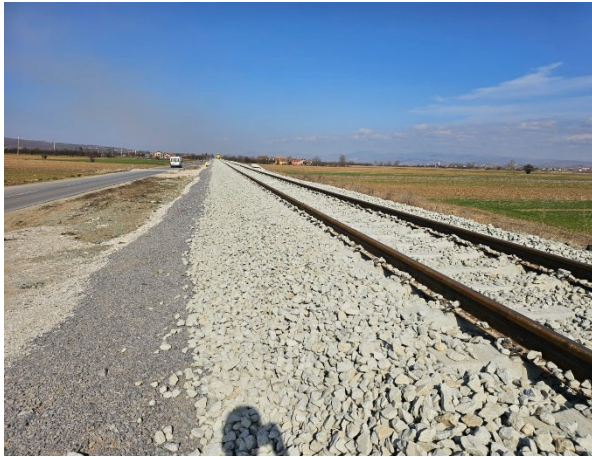
Figura 35 Vendosija e shtresës së dytë të ballastit
