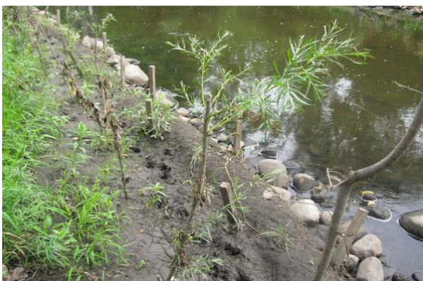
Figura 18 Mbrojtja e brigjeve me drunjë të gjallë http://www.goldenvalleymn.gov/stormwater/stream-bank-stabilization.php
