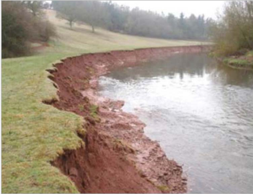
Figura 23 Erozioni i bregut pas largimit të argjinaturave. Burimi: Natural Resources Wales
