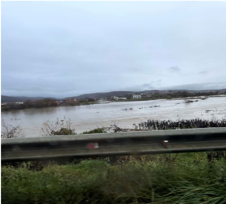
Figura 49 Viti i parë pas vendosjes së gabioneve dalja e lumit nga shtrati (foto nga terreni, 2022)
