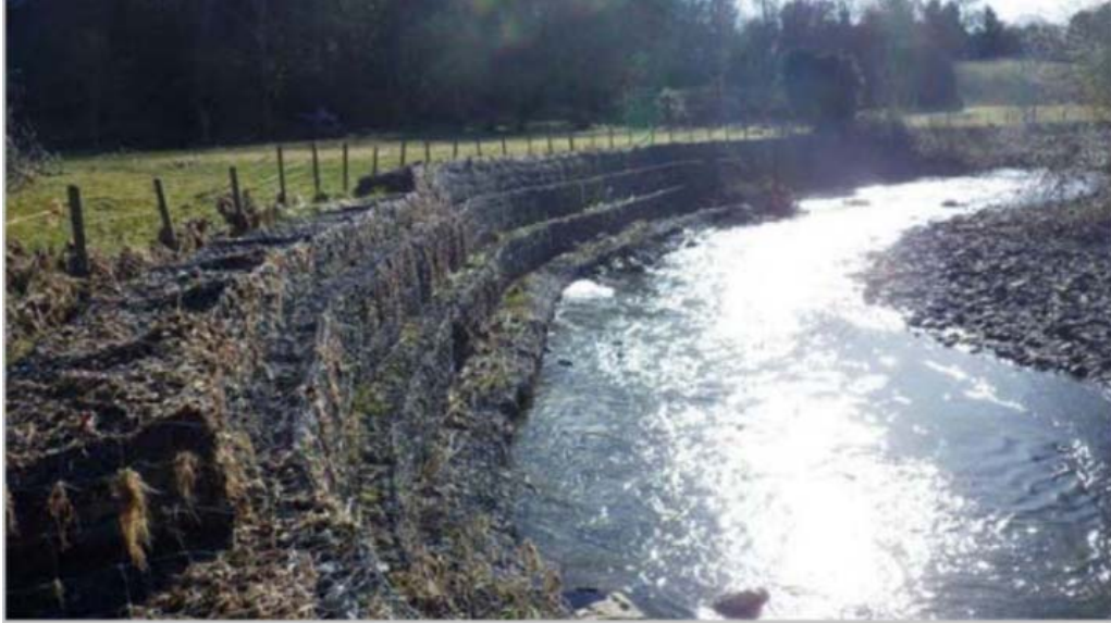
Figura 20 Dështimi i mbrojtjes së bregut me gabion
