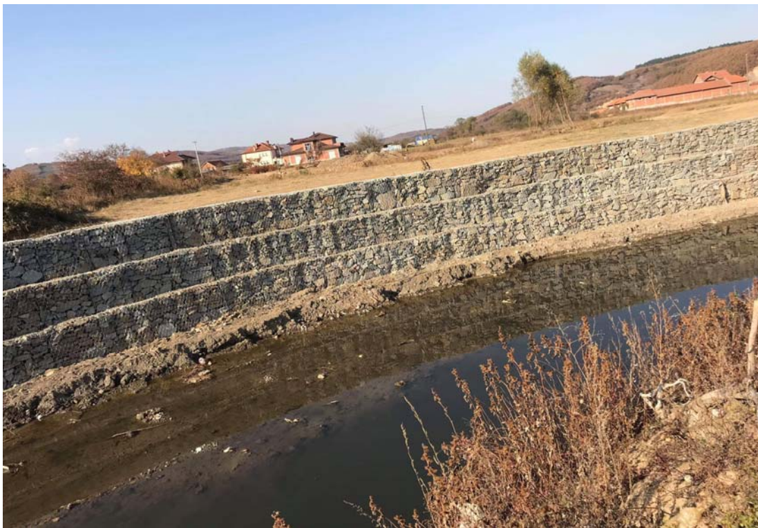
Figura 48 Mbrojta e kthesave me gabion
