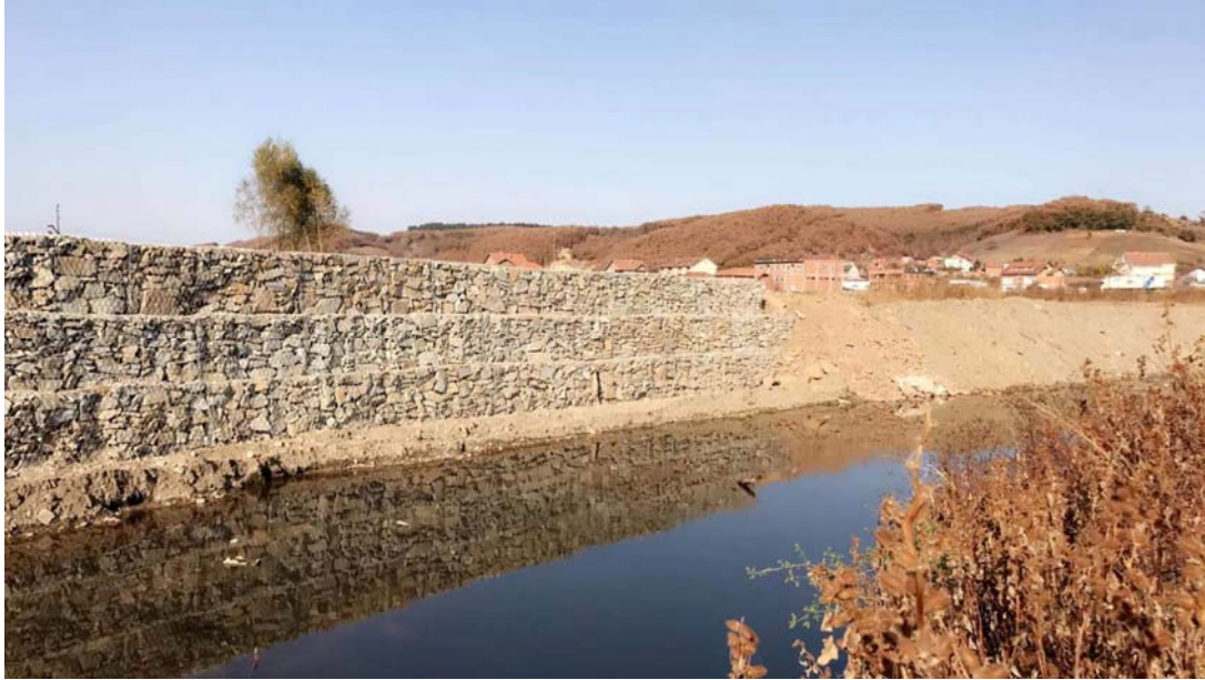
Figura 47 Pamja pas instalimit të gabionve
