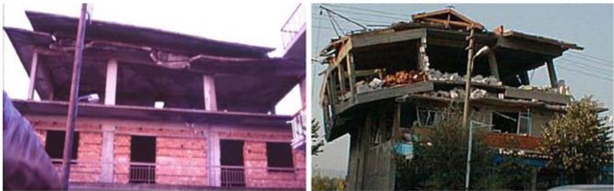
Figura 2.3: Rrëzimi i kateve të sipërme me dimensione të reduktuara në plan (majtas): Kalamata (GR) 1986; (djathtas): Kocaeli (TR) 1999
