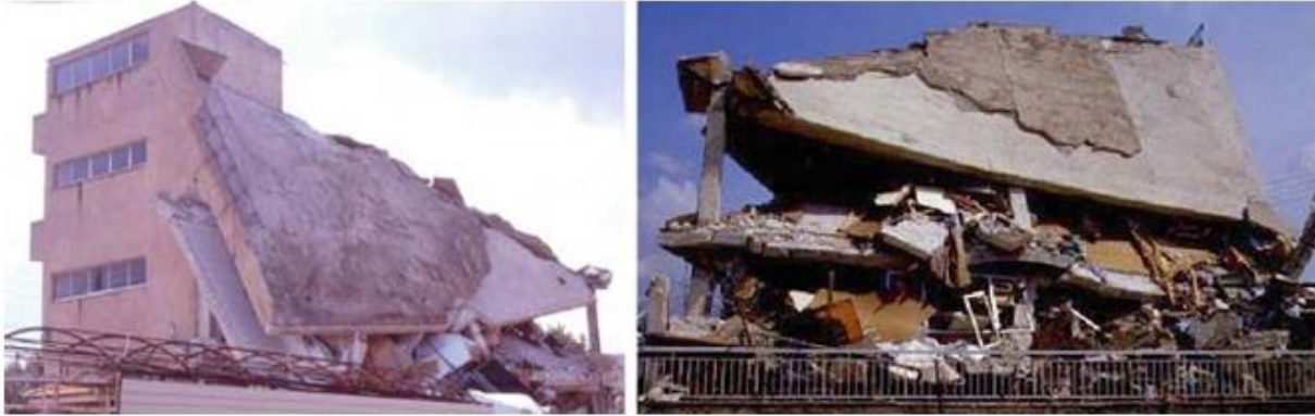
Fig. 2.1 Rënja e një ndërtese për shkak të përgjigjes përdredhëse rreth një trangu të fortë në një kënd, tërmeti i Athinës (1999)
