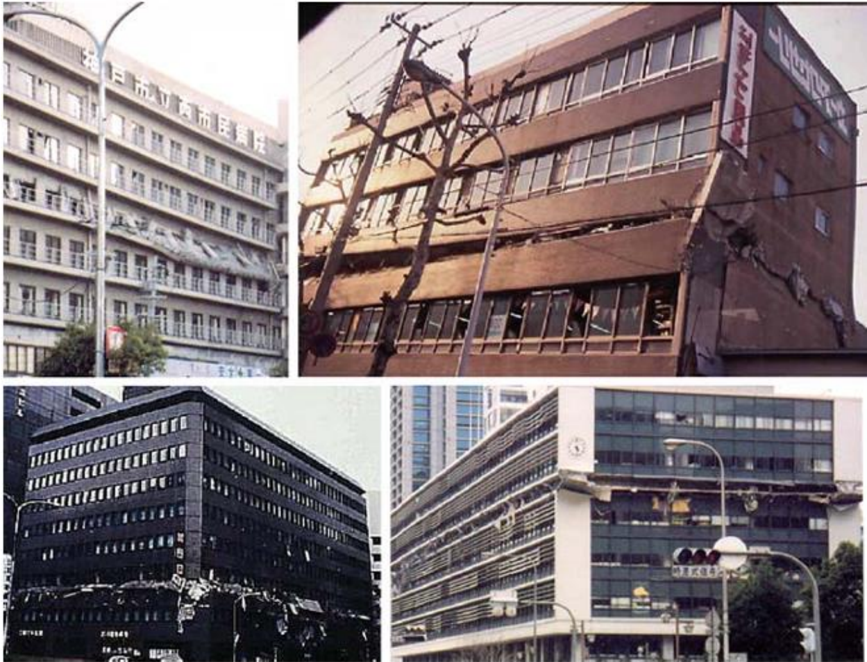
Figura 2.4: Rrëzimi i kateve mesatare për shkak të ndryshimeve të menjëhershme në ngurtësi ose rezistencë të elementeve vertikale (Kobe 1995)
