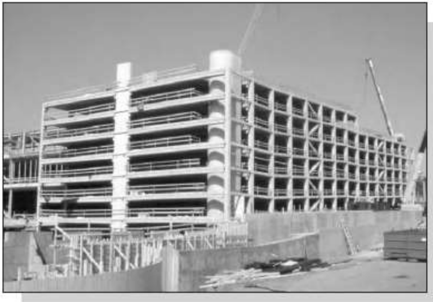
Fig 1.5 Struktura prej elementeve të betonit të parapërgatitur – ‘‘Molla e Gjelbërt’’ në Finland
