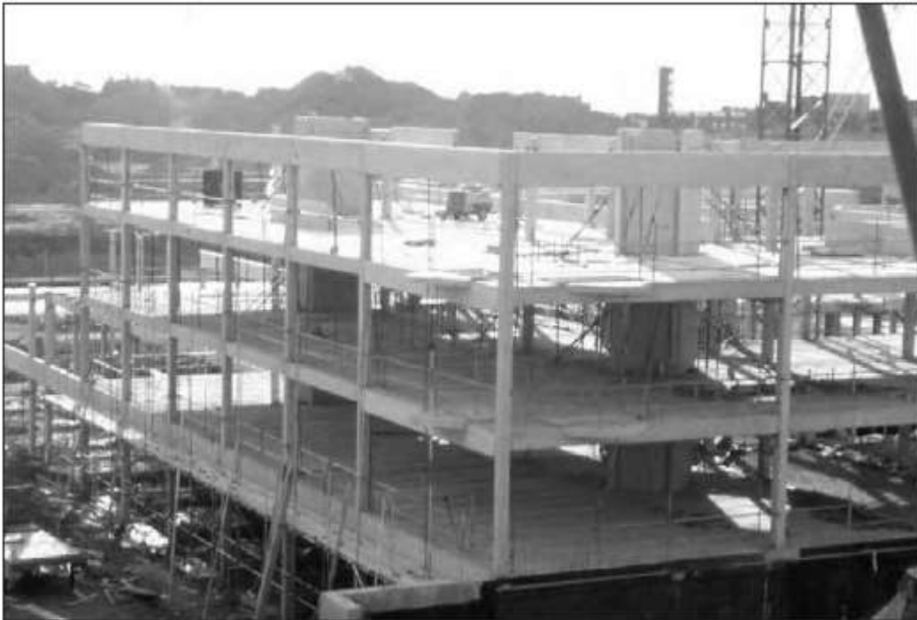
Fig 3.1 Sistem skeltor nga elemente e parafabrikuar
