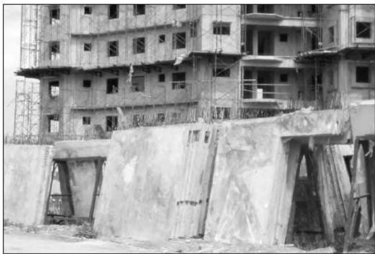
Fig 1.2. Elementet e parapërgatitura në afërsi të objektit
