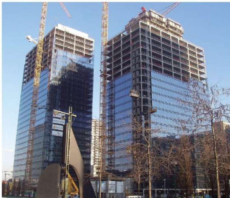
Fig 7. Ndërtimi i Kullave Binjake në Bruksel në 36 Kate me elemente të parafabrikuar
