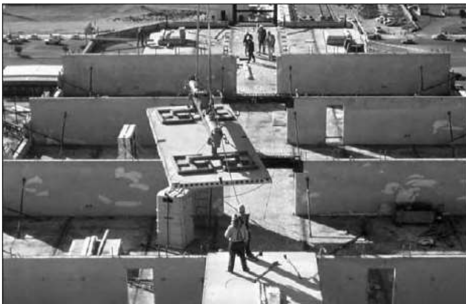
Fig.3.3 Sistemet me mure dhe pllaka të lehtësuara në distancë 3.6 m'
