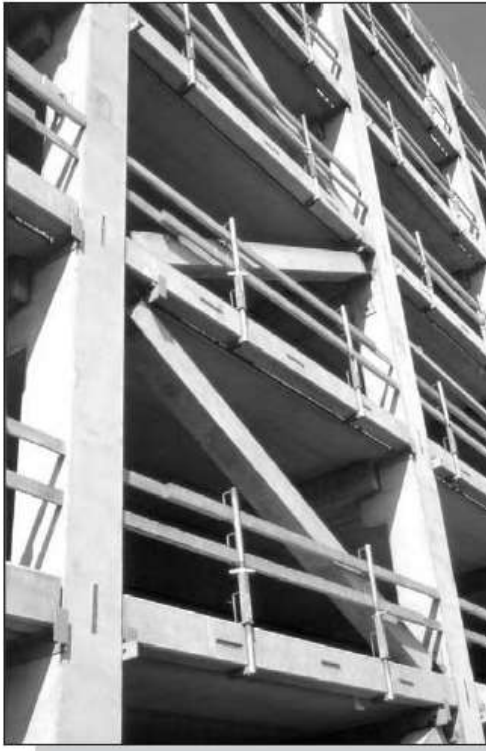
Fig 3.4.5 Mbjajtësit diagonal nga betoni ose çeliku
