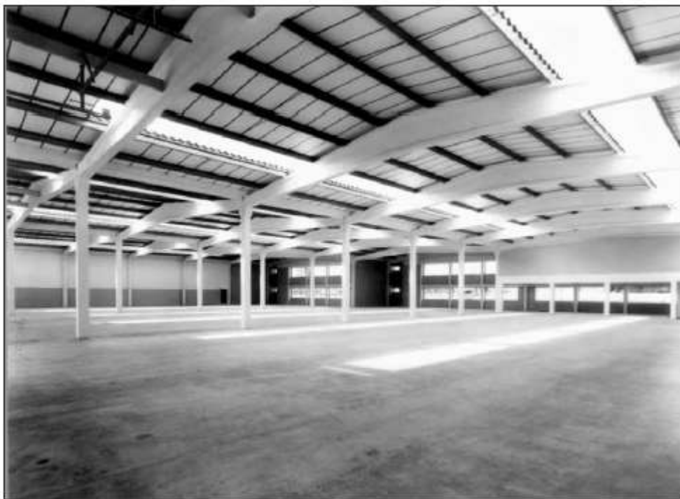
Fig 3.6 Nje shembull i ndërtimit të një objekti me hapësira të mëdha prej elementeve të betonit të parapërgatitur
