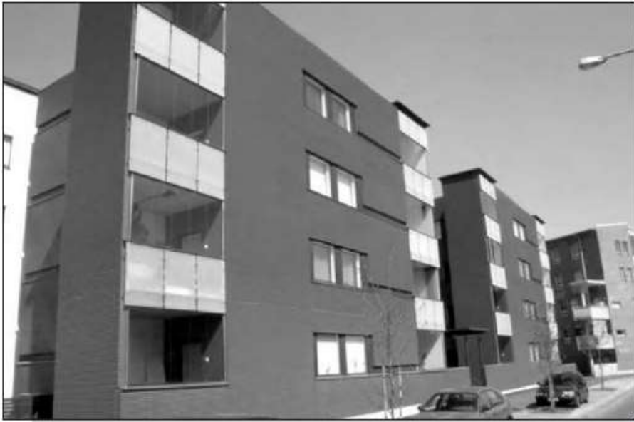
Fig 3.3 Fasada në muret mbajtëse të parapërgatitura
