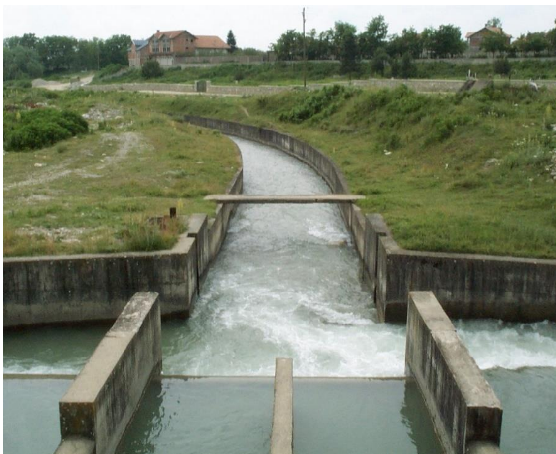
Figura 2.8. Kanali shkarkues në pjesën e poshtme të kapërderdhësit.
