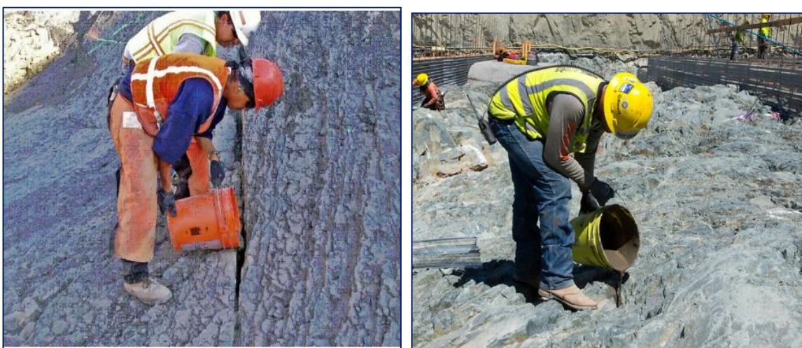
Figura 3.15. Injektimi i çarjeve me llaç çimentoje.
