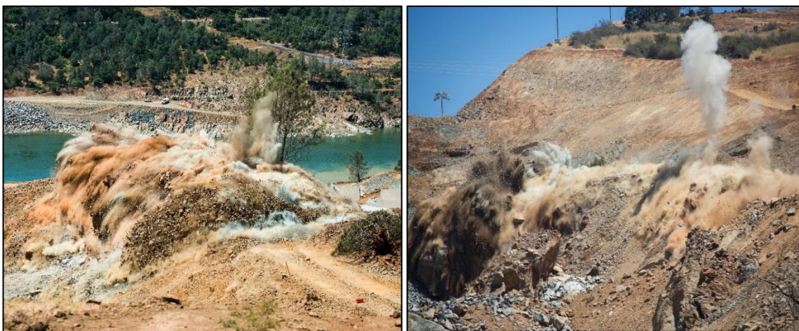
Figura 0.5. Përgatitja e bazamentit shkëmbor (CDWR, 2017)
