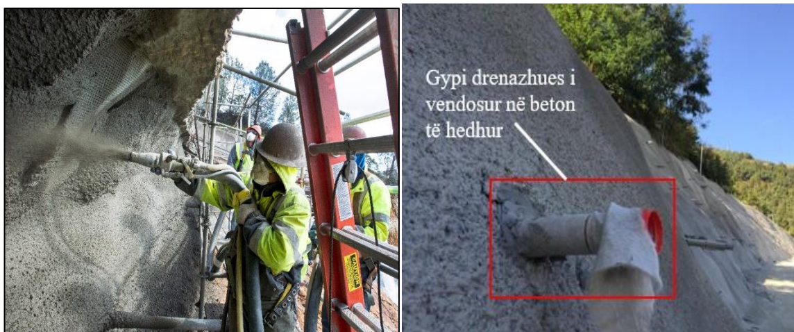
Figura 3.10. Trajtimi i themelit dhe skarpateve me beton të spërkatur (shotcrete)
