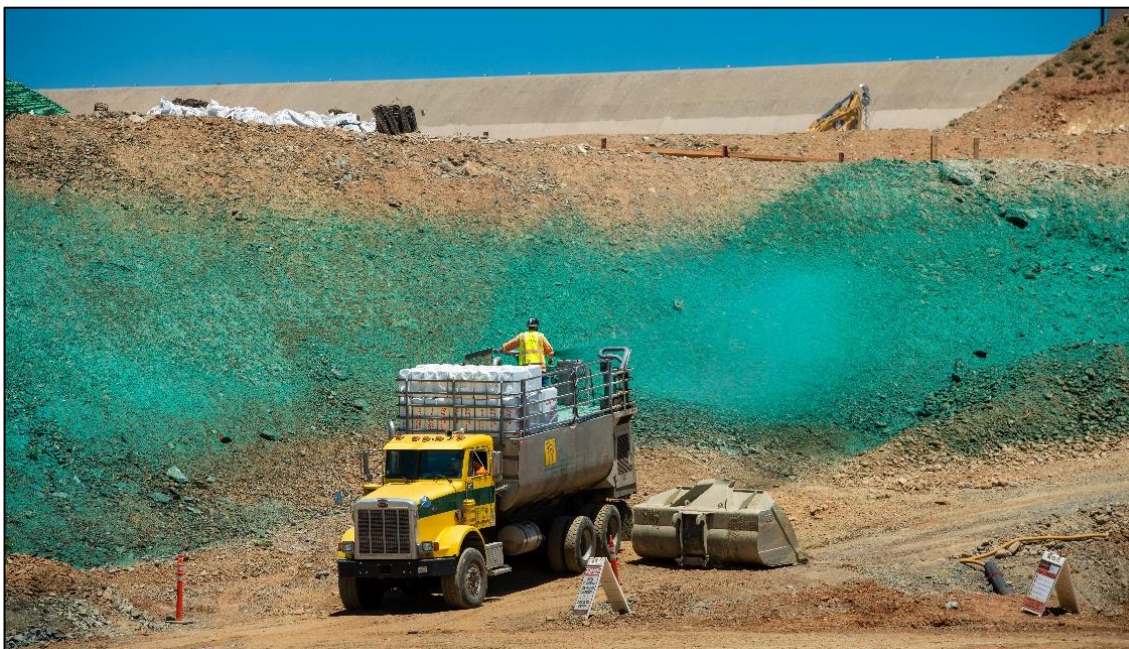
Figura 0.6. Aplikimi i hydromulch-it në kapërderdhësin emërgjent në penden Oroville (CDWR, 2017)
