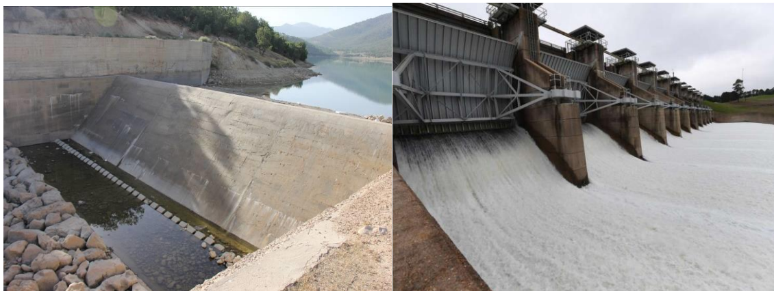
Figura 0.3. Kapërderdhës bregor pa porta. Figura 3.5. Kapërderdhës me porta radiale për kontrollin e shkarkimit.
