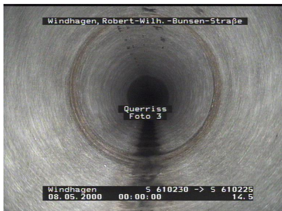
Figura 14 a), b). Sanimi i plasaritjeve me metodën Quick-Lock në një rrjet të kanalizimit në Gjermani (Hochschule Wismar, 2023)
