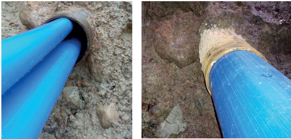
Figura 8 a), b). Tubi i palosur gjatë futjes në tubin ekzistues dhe zgjerimi i tij (Rohrbau, 2013)
