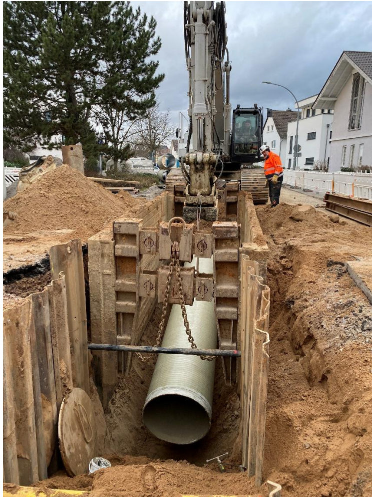
Figura 2. Instalimi i rrjetit të kanalizimit me hapje të kanaleve (Ramadanaj, L)
