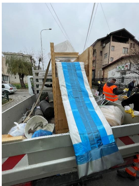
Figura 15 a), b). Tubi i palosur dhe gjendja pas futjes në tubin ekzistues, Prizren (Ramadanaj, L)
