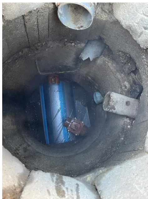
Figura 15 a), b). Tubi i palosur dhe gjendja pas futjes në tubin ekzistues, Prizren (Ramadanaj, L)
