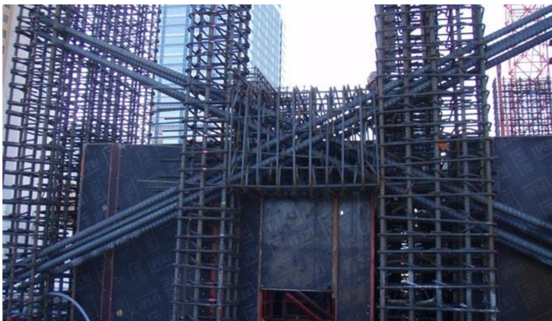
Figur 8.6 -Rasti i përforcimit me armaturë të formës X- hapësirat mbi hapje (tek trajet e çiftezuara).
