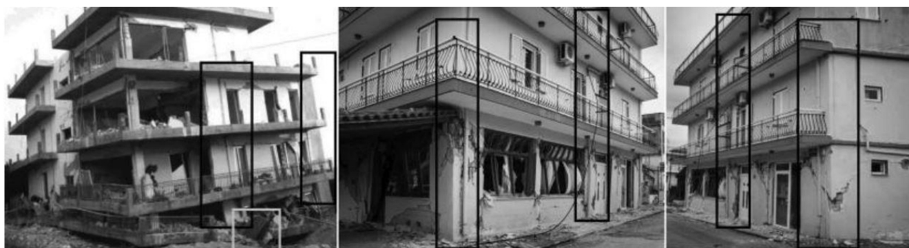
Figura 2.7 -Roli i mureve në parandalimin e shkatërrimit të objekteve
