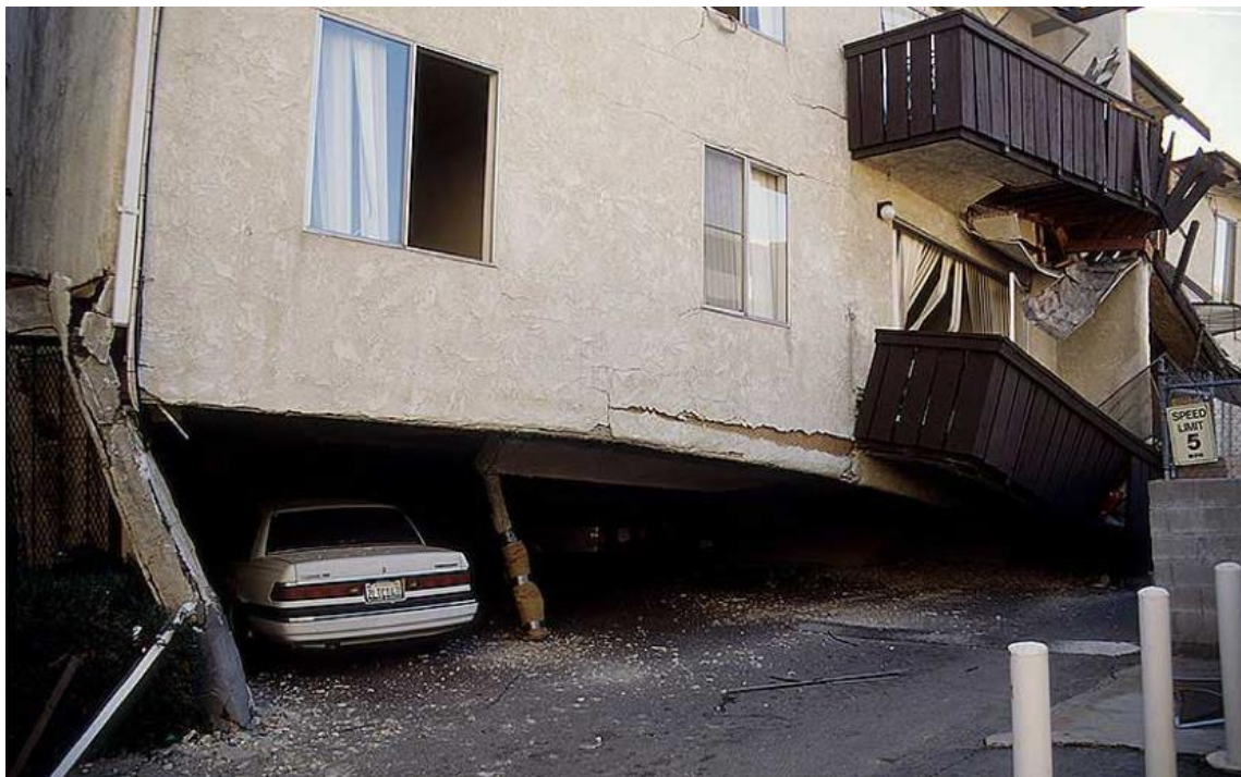
Figura 2.6 -Shkatërrimi i një objekti si rezultat i katit të butë (soft story)
