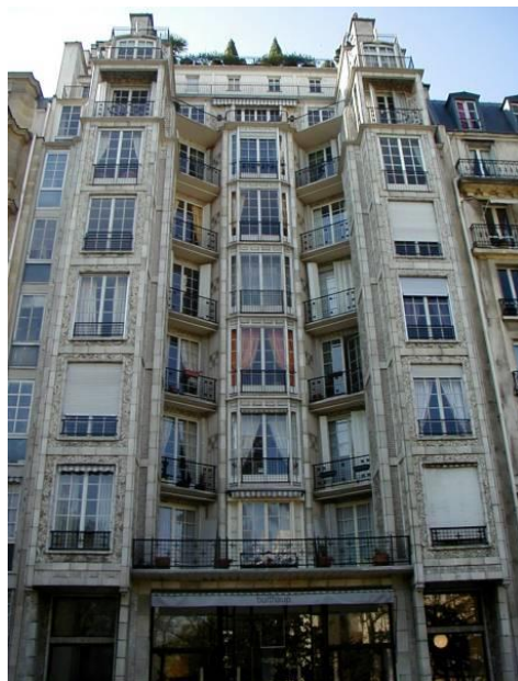
Figura. 12. Ndërtesa e parë e projektuar me shtylla, traje, pllakë të përforcuar më çelik , Francë
