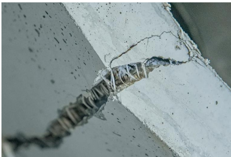
Figura. 3. Efekti I fibrave në rastin e plasaritjes së betonit
