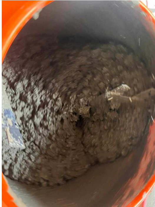
Figura. 57. Vendosja e sasisë së betonit në përzierse
