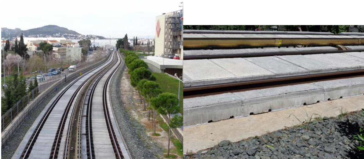
Figura. 37. Piraeus - Athinë, Hekurudha elektrike, seksioni 1
