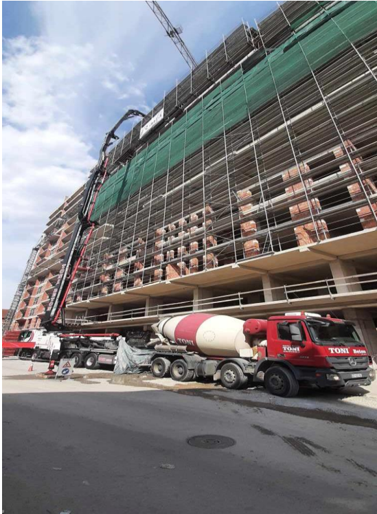
Figura. 49. Bartja e përzierjes së betonit me mikser në punishte
