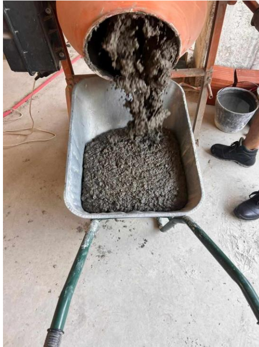
Figura. 59. Hudhja e masës së betonit të përzier me fibra në karrocën e dorës
