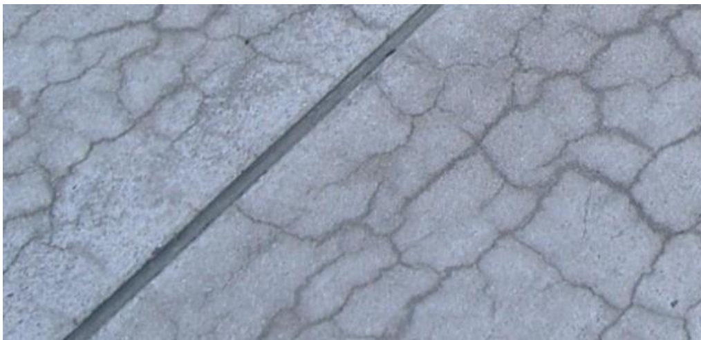
Figura. 18. Reaksioni Alkalo - silikat në beton.
