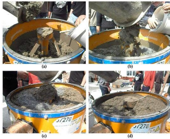
Figura. 28. Përzjerja e fibrave në beton, a) Vendosija e betonit në përzjerse, b) dhe c) Vendosija graduale e fibrave në masën e betonit të njomë, d) Beton I përzier me fibra
