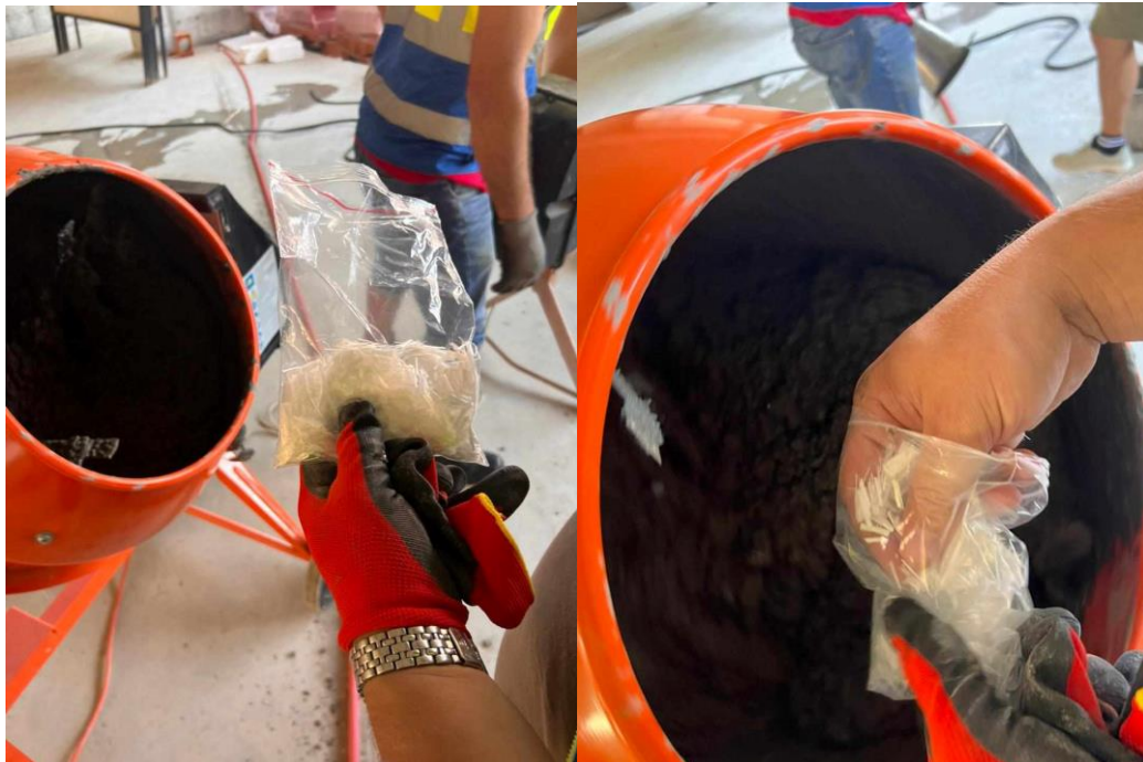
Figura. 58. Hudhja e fibrave në masën e betonit në përzierse në mënyrë manuale
