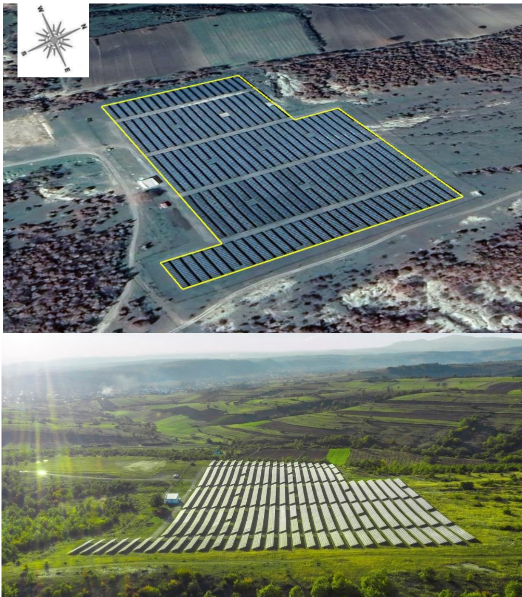
Figura 8 – Paraqitja e paneleve solarë në Novosellë – Kamenicë Burimi: a) Google Earth, b) Jaha Solar ( www.jahasolar.com/ )
