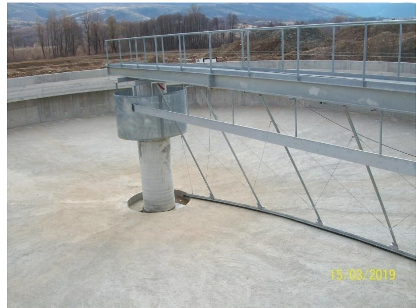
Sedimentuesi sekondar pas instalimit të urës lëvizëse për largimin e lymit të sedimentuar
