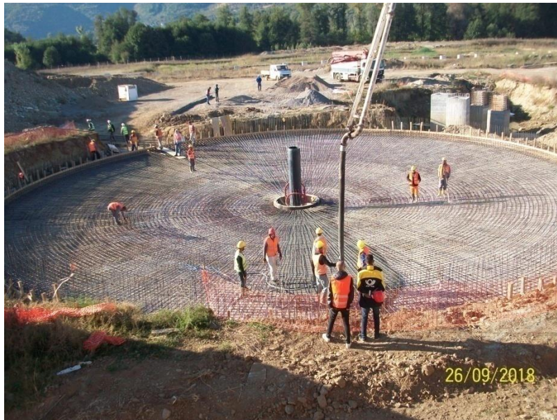
Armimi dhe betonimi i bazamentit të sedimentuesit sekondar
