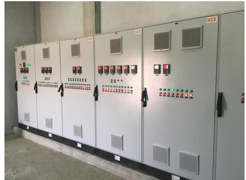
Instalimi i paneleve elektrike komanduese MCC
