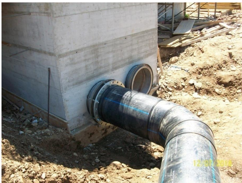
Instalimi i gypave HDPE të procesit dhe lidhja e tyre me fillanxha të vendosura në strukturat e betonit
