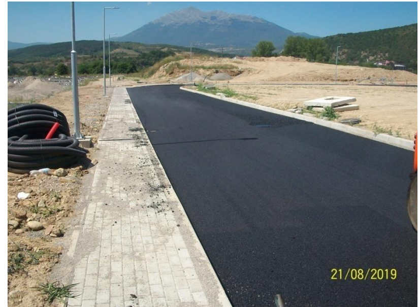
Asfaltimi i rrugëve brenda impiantit
