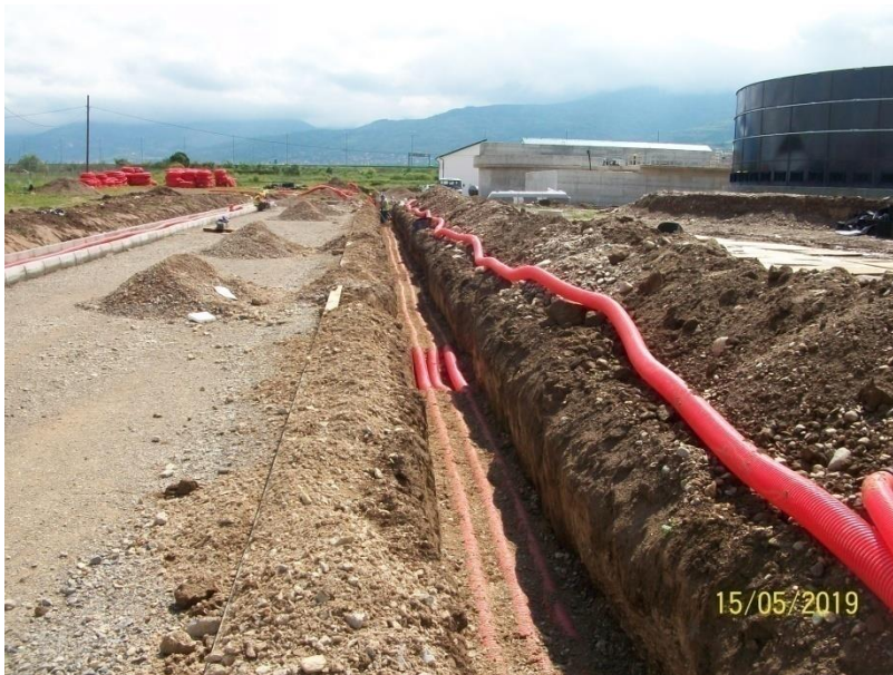
Instalimi i tubacioneve për vendosjen e kablove elektrike furnizuese dhe shpendarëse nëpër objekte
