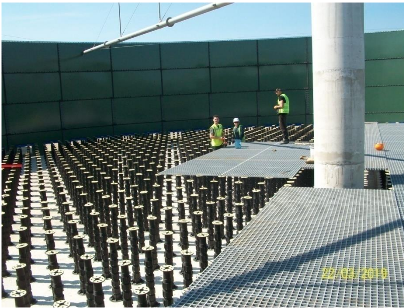
Instalimi i platformës drenazhuese të filterave me pikim
