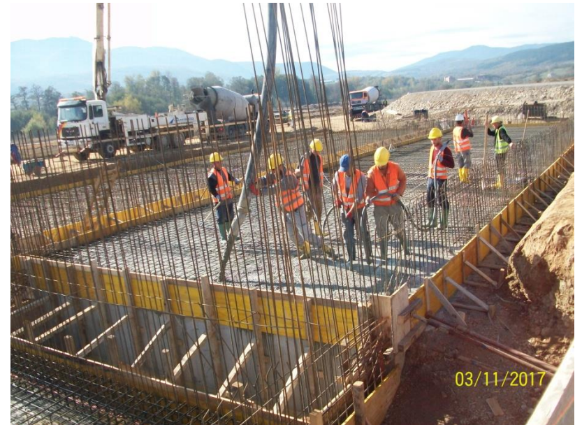
Procesi i betonimit të bazamentit të sedimentuesit primar
