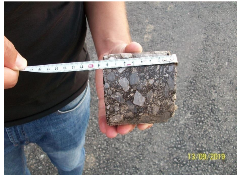
Matja e trashësisë së asfaltit pas nxjerrjes së kernës
