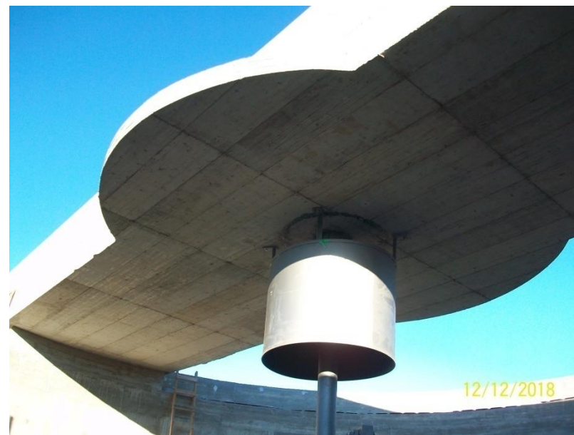
Pllaka e sipërme e trashësit të lymit në të cilin është i fiksuar boshti i përziërsit dhe motori.
