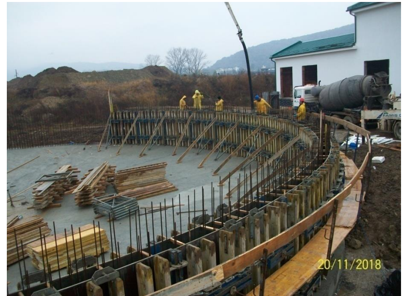
Procesi i betonimit të mureve të sedimentuesit sekondar
