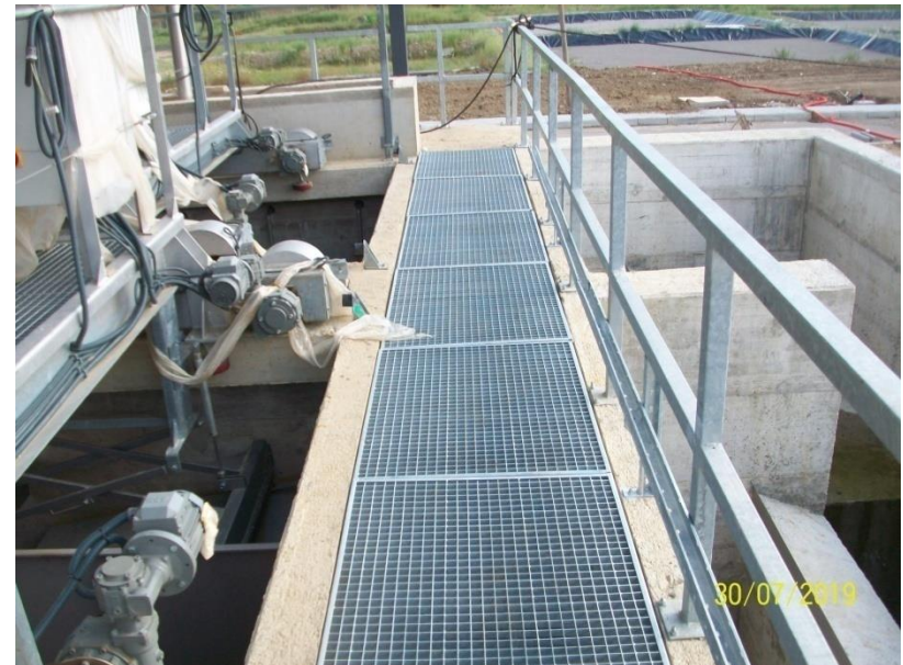
Instalimi i grilave dhe rrethojës siguroese në objektin e sedimentuesit primar
