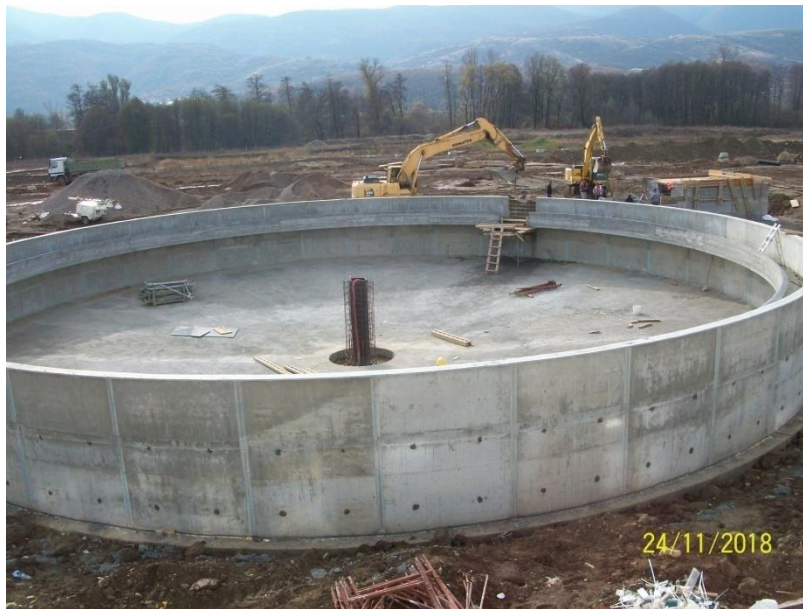
Punët finale të betonimit të sedimentuesit sekondar
