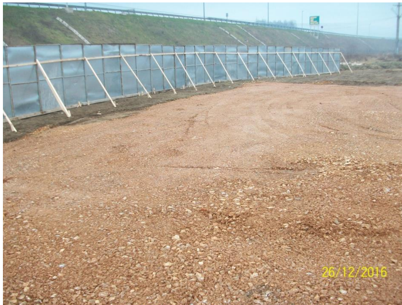
Punimi i rrethojës së përkohëshme të kantierit
