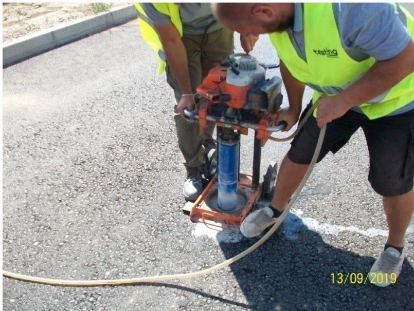
Nxjerrja e kernave për testimin e shtresës së asfaltit
