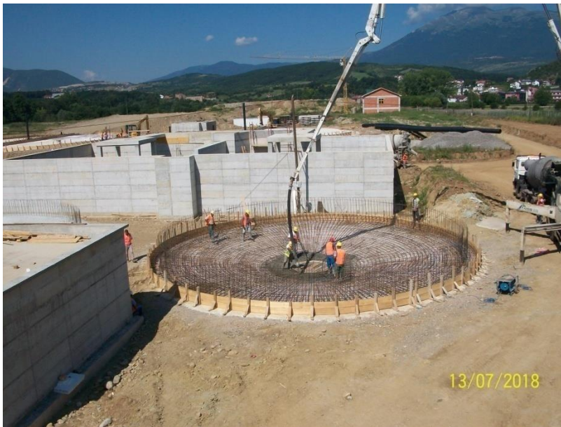
Armimi dhe betonimi i bazamentit të trashësisë sekondar të lymit
