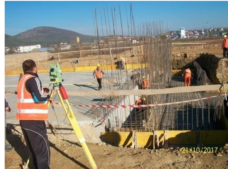
Verifikimi i kuotave dhe armimi i bazamentit të sedimentimit primar
