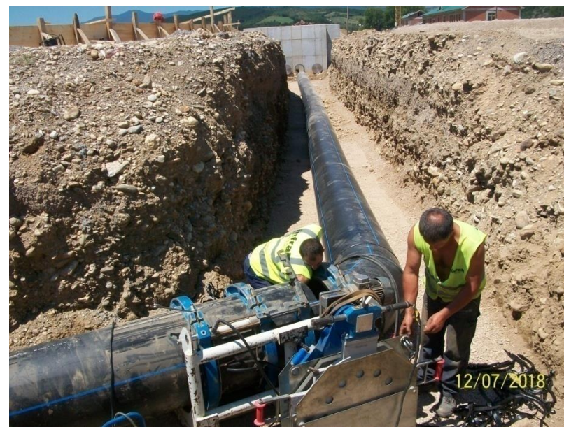
Saldimi dhe instalimi i gypave HDPE të procesit
