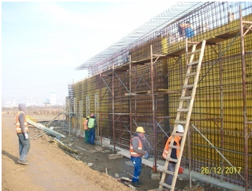
Latimi dhe armimi i mureve të rezervoarit të tretësit aerobik
