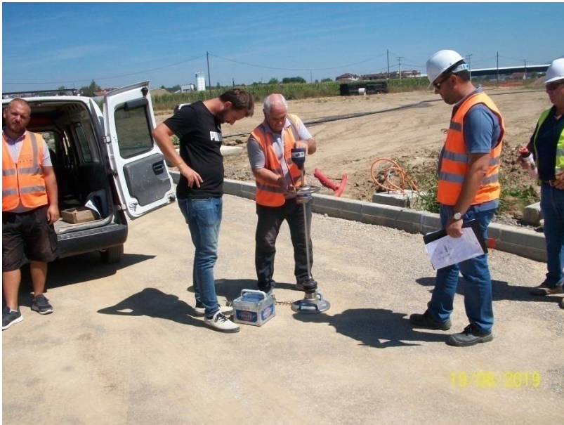
Testimi i ngjeshmërisë së tamponit të rrugëve brenda impiantit
