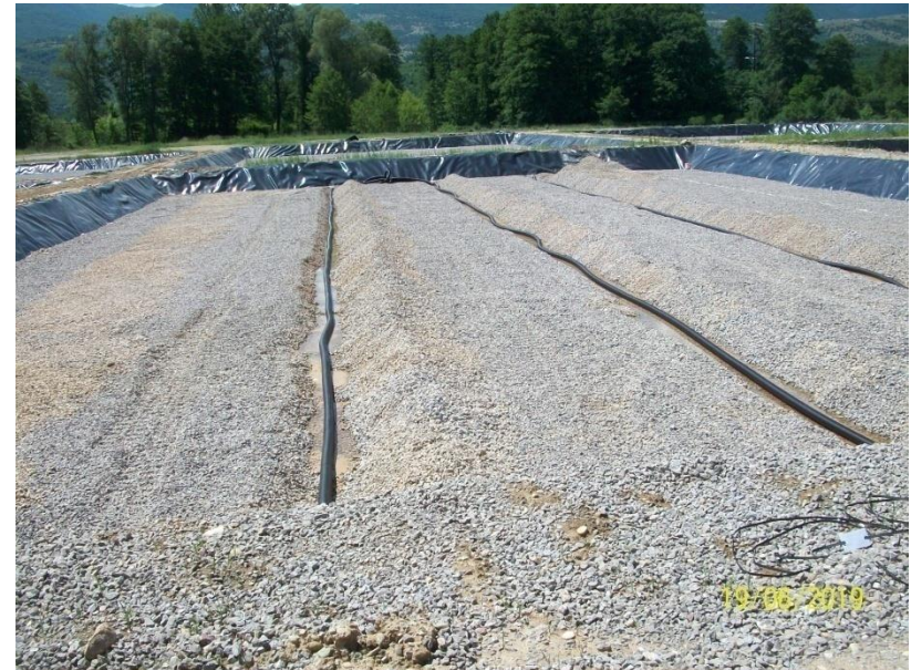
Instalimi i gypave të drenazhës dhe shtresës zhavorrike drenazhuese në shtretërit për stabilizim të lymit
