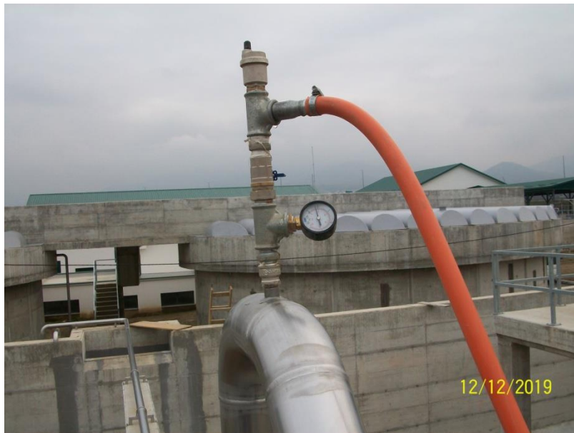
Testimi në presion i gypave të inoksit dhe procesit
