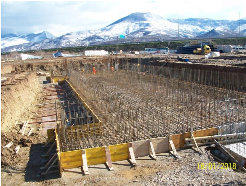
Armimi i bazamentit të objektit të paratrajtimit Ndarësi i rërës dhe yndrave
