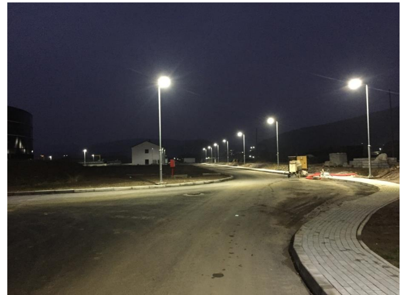
Testimi funksional i ndriçimit të rrugëve të Impiantit
