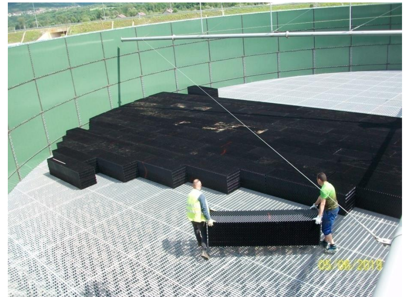
Instalimi i masës plastike brenda mureve të filterave me pikim
