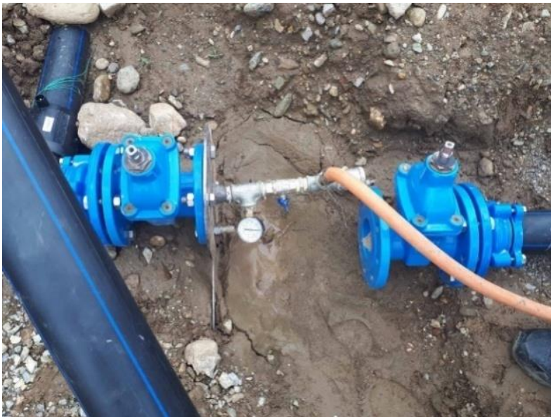
Testimi në presion i gypave HDPE të procesit
