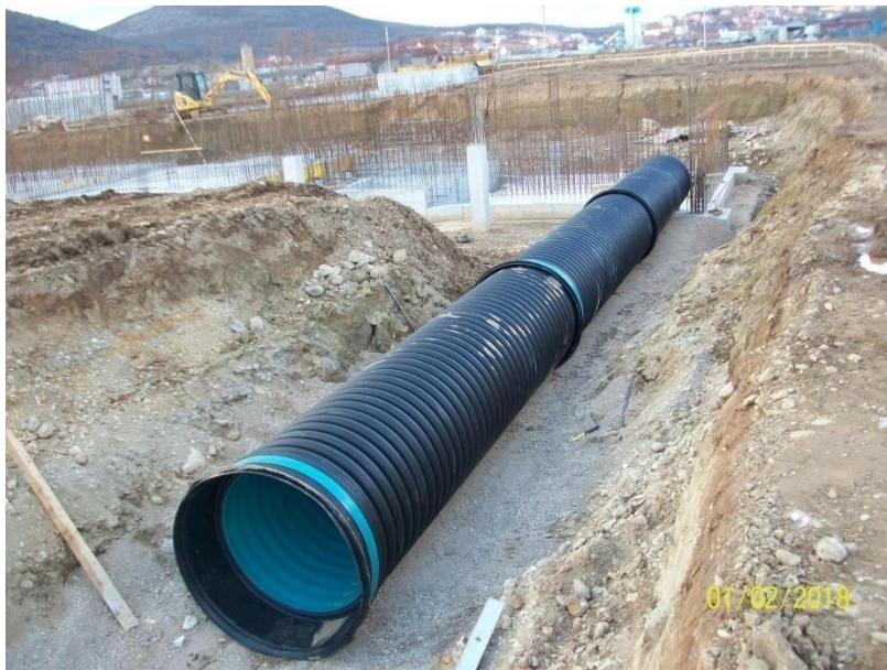
Vendosja e gypave të polipropilenit për pjesën hyrëse të ujërave të ndotura në trajtim
