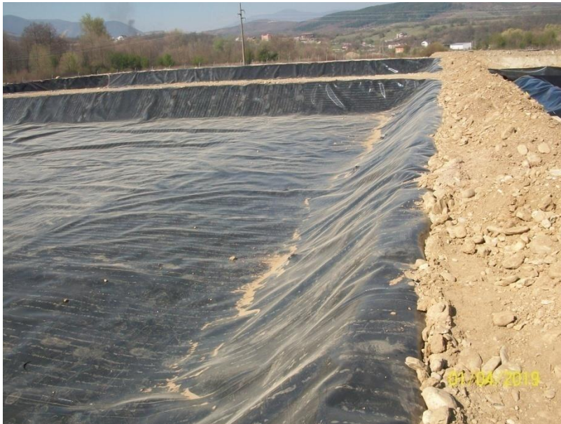
Instalimi i geomembranës në shtretërit me kallamishte për stabilizim të lymit
