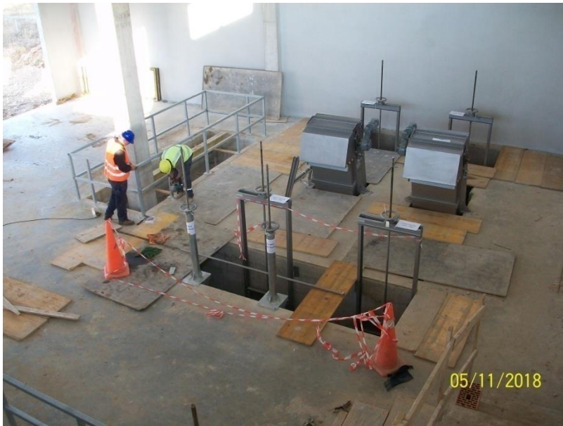
Punime gjatë procesit të instalimeve të pajisjeve në objektin e paratrajtit
