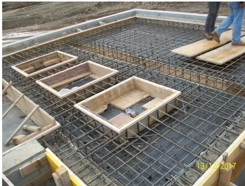
Latimi dhe armimi i pllakës së stacionit të ndërmjetëm të pompave
