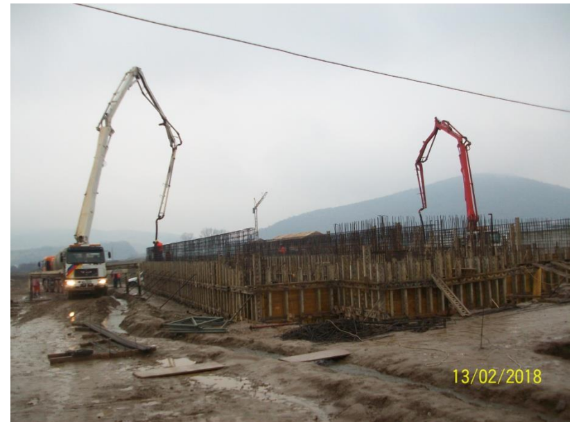
Procesi i betonimit të mureve të objektit të sedimentuesit primar
