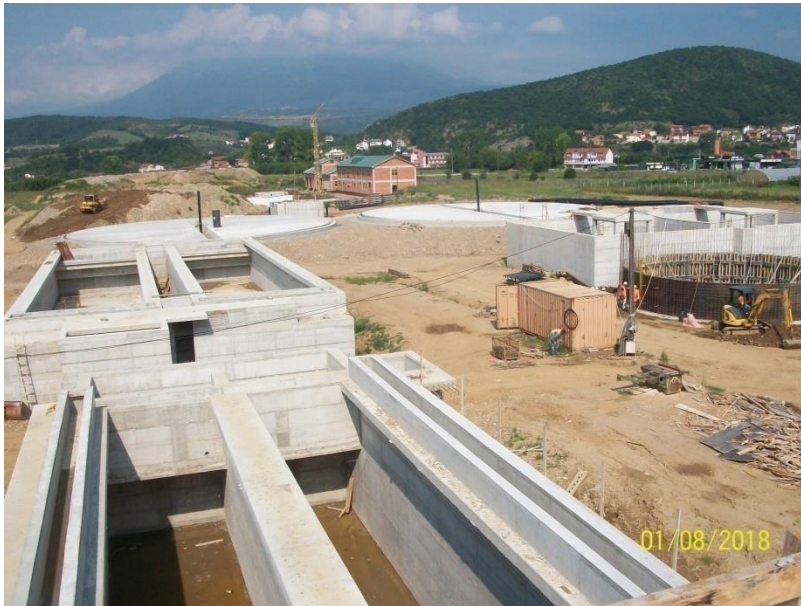
Punët në përfundim të strukturave të betonit
